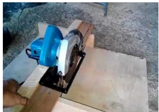
Gambar 6 Pemotongan dan Pemasangan Papan
