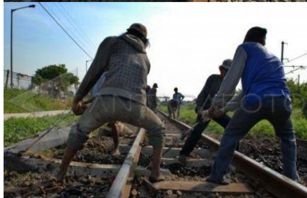
Gambar 5: Penggantian bantalan rel di jalur stasiun Kampung Bandan-Jakarta.
