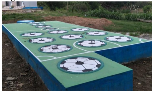
Gambar 5. Memanfaatkan mainhole sebagai obyek pada Bangunan SPALD-T
