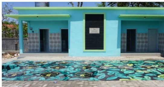
Gambar 6. Memanfaatkan mainhole sebagai obyek pada Bangunan SPALD-T
