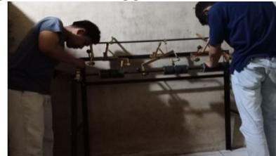
**Gambar 16. Proses Pemasangan Bonet**
