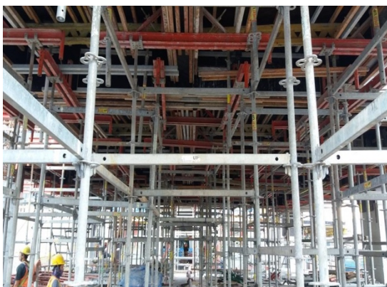
Gambar 3.2 Bentuk Bekisting Peri Up
